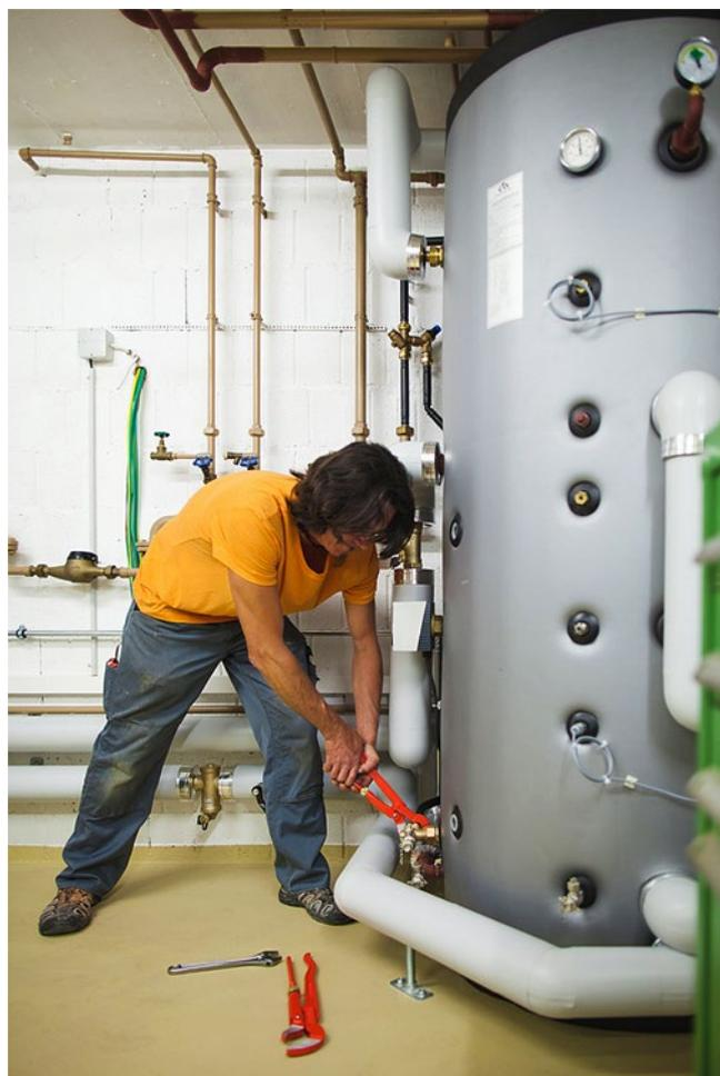
[FIG. 4] Controllo dell'ermeticità sull'accumulatore.
